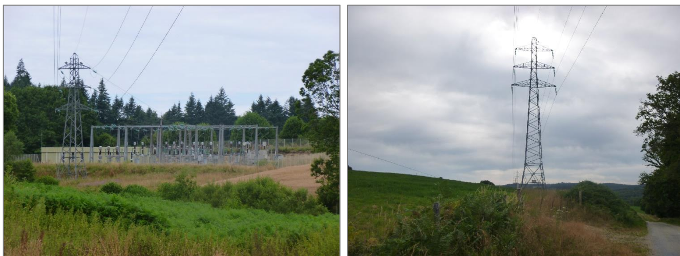
Photographie 20 : Poste électrique de Mansat et ligne HT La vaud-Mansat (source : ENCIS Environnement)
