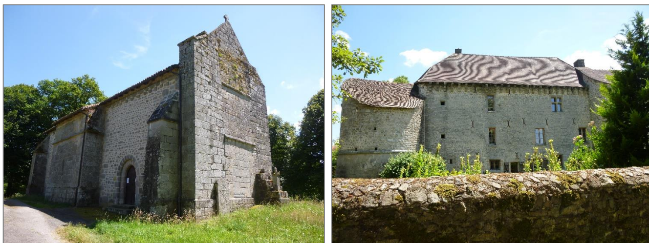
Photographie 17 : Eglise de Thauron et château à Mansat-la-Courrière (source : ENCIS Environnement)
